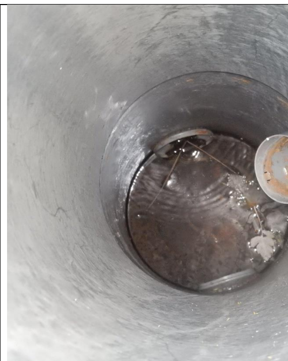
Inspectie aansluitingen doorspuit put
