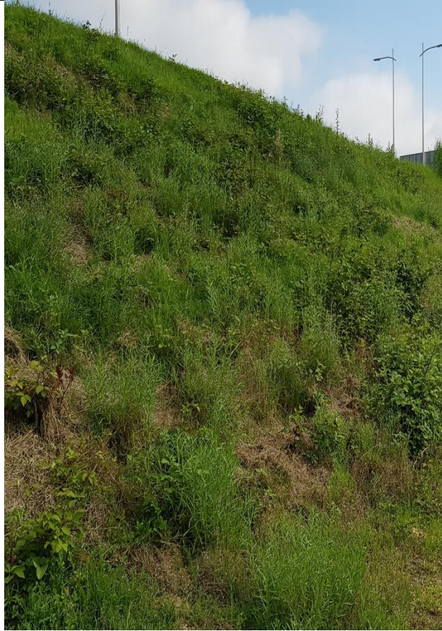
Inspectie IBC werk
